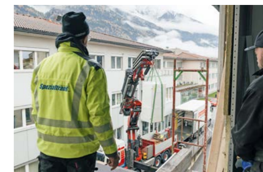
Einbringung des 1,5T-MRT Vantage Orian in das Ärztehaus 1 in Telfs
